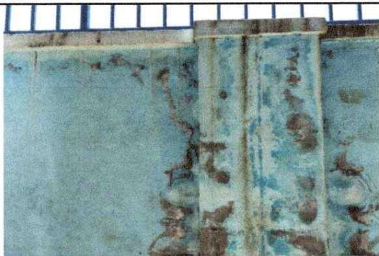
Foto 1: Pintar en la parte interna del muro de la circulación lado oriente.
