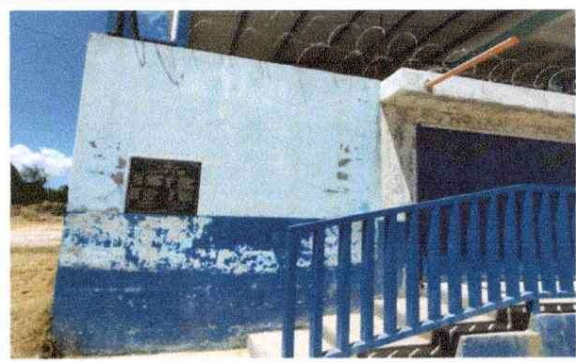
Foto 4: Pintar en la parte externa del muro de la circulación del establecimiento, lado: Norte, Sur, Este y Oeste.
