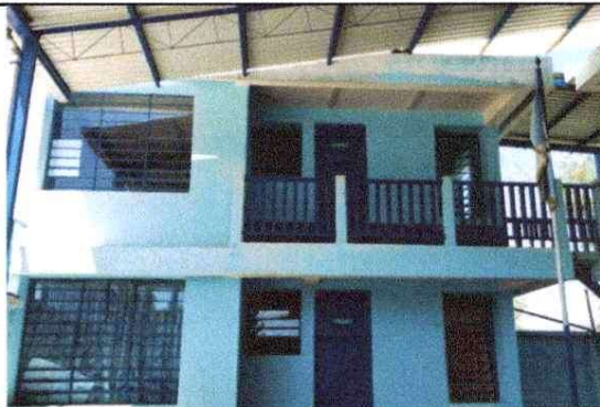
Foto 2: Pintar en la parte interna y externo de la pared de la dirección y bodega lado sur.
