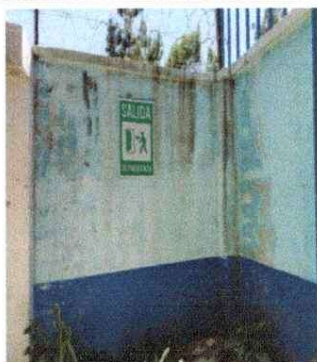
Foto 3: Pintar en la parte interna del muro de la circulación lado norte.
